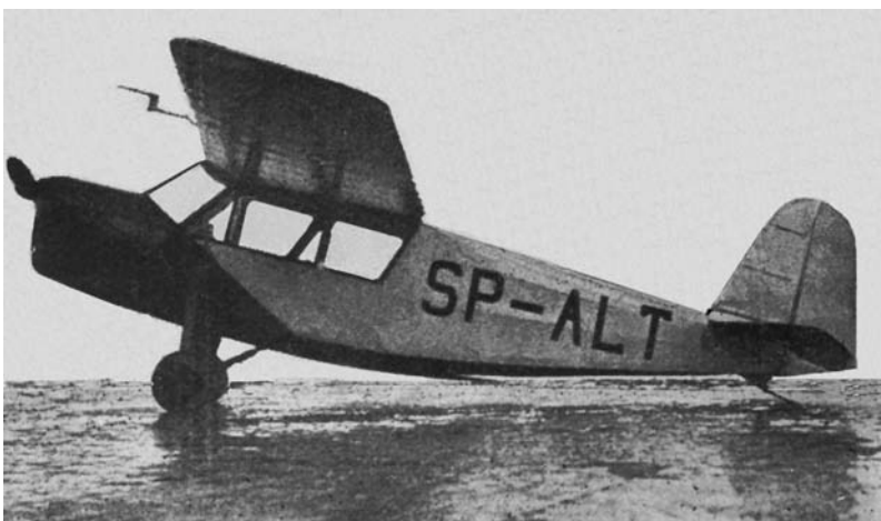
Samolot SP-ALT – z trzeciej serii produkcyjnej. Idealna ilustracja lewej powierzchni kadłuba. Brak owiewek świadczy, że samolot nie pełnił funkcji reprezentacyjnej i był przeznaczony do normalnej eksploatacji w aeroklubach
